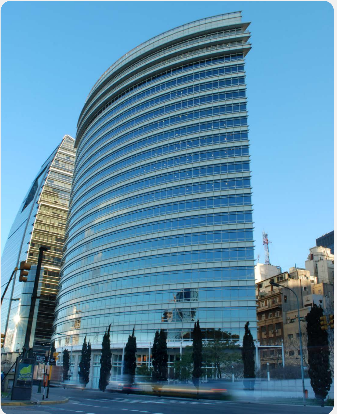
Edificio Republica - Ciudad de Buenos Aires - 19.885 m2
